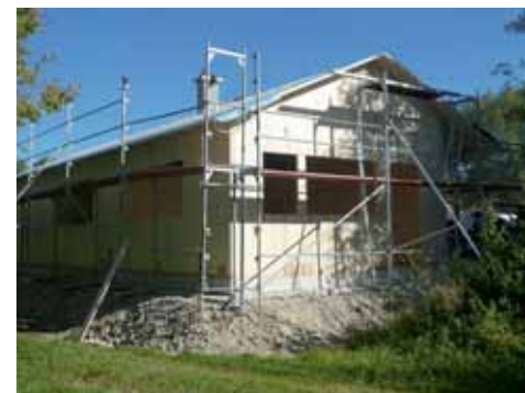
Rohbau der Station im Oktober 2018
